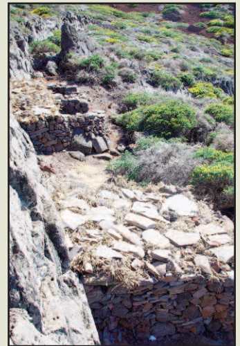
Abrigos pastoriles reutilizados en la Deggollada del Fraile (Roque de Los Muchachos. Garafía)
