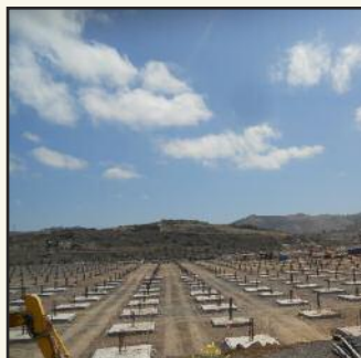
Cambio de rolos por columnas
