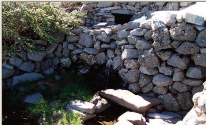
Fuente Nueva (Cumbre de Garafía)
