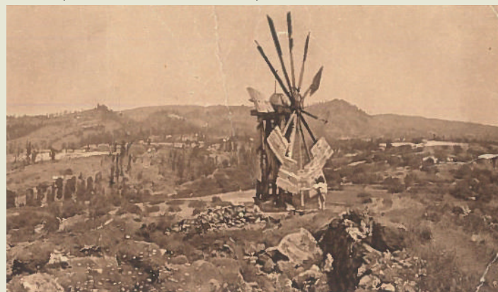
Molino de viento de Las Tricias (Garafía), foto de principios del siglo XX. En ella se observan las aspas entrelazadas con traperas que resistían bien los embates del viento. En los molinos supervivientes actuales solo se aprecian las aspas con aspecto desnudo.
