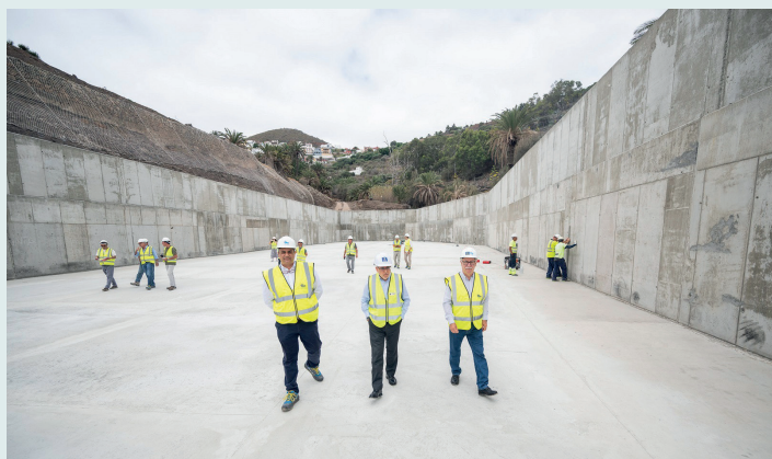
Depósito de la EDAR de Barranco Seco (Foto Cabildo de Gran Canaria)
